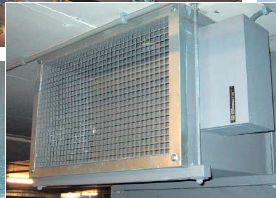
Entrauchungsklappe mit temperaturbeständiger Antriebsumhausung.
