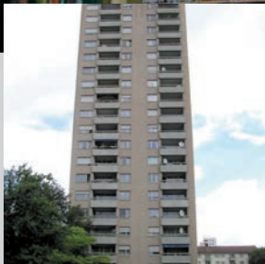
Hochhaus Schwandenholz, Zürich
